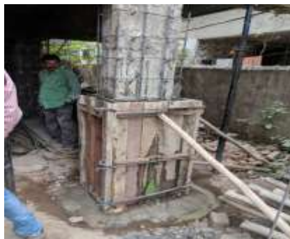
Fig. 8. Column Jackeing
